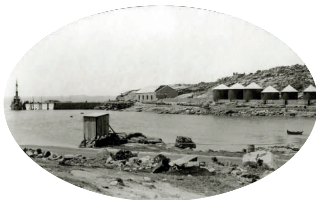
Caneliñas en 1925 co peirao á esquerda, o almacén de fertilizante no centro e seis contedores de almacenamento de aceite á dereita © Arquivo de Álex Aguilar
